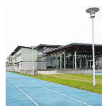
Die Mehrzweckhalle braucht eine neue Heizung. Bild: H. Bärtschi
